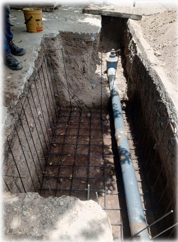
Foto 17 -19. Instalacion Macromedidor
