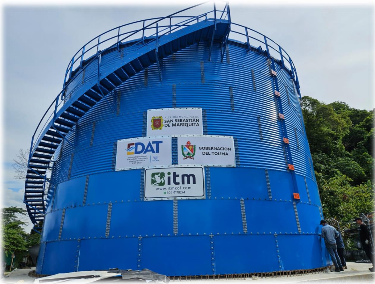
Foto 1. Tanque de almacenamiento
