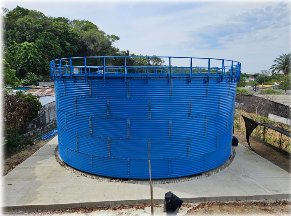
foto 3. Cimentación y tanque de almacenamiento
