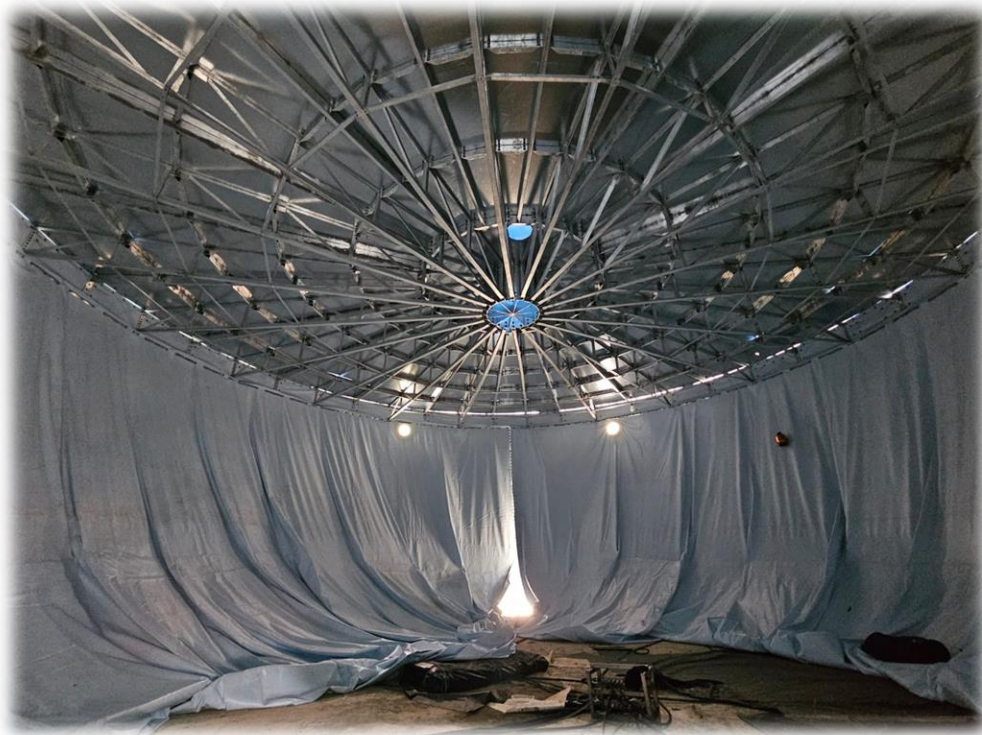
Foto 2. Interior Tanque de almacenamiento
